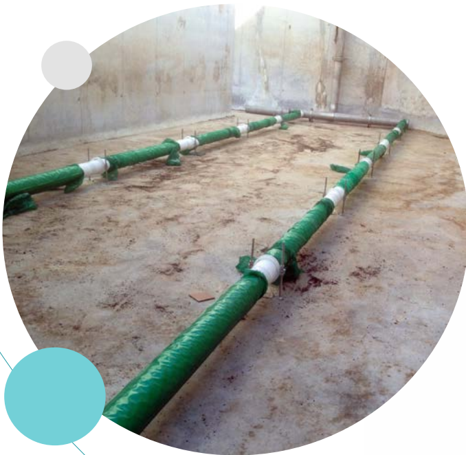
EKOTON 曝气系统装配在荷 兹利亚污水处理厂, 以色列
